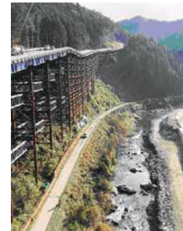
ダム湖左岸の工事用仮設道路も「岩盤すべり」を避けて 巨大な鉄骨組構造に変更された
